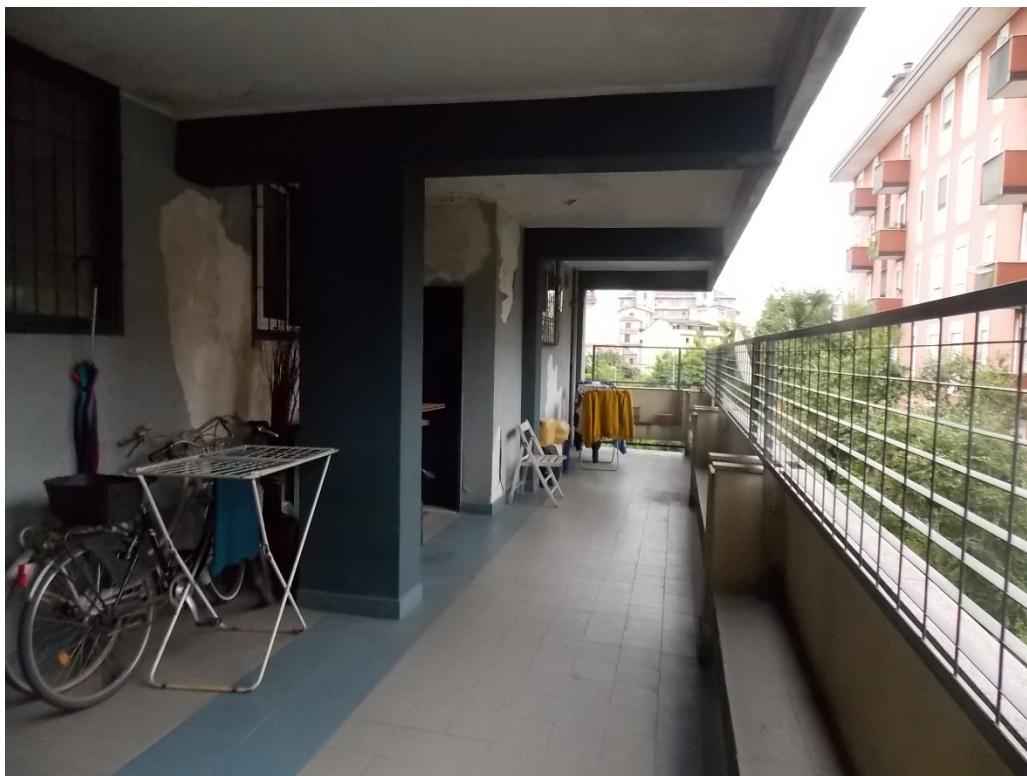
Foto n. 4: Ballatoio di accesso all'appartamento
